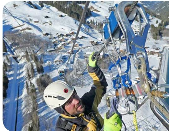
Bei der Kabine muss die Seilrolle umgehängt werden, damit die Bergung zweier Figuranten zur Talstation am gleichen 1000-m-Seil durchgeführt werden kann.
