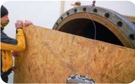
Freilegung des Eingangs zur Druckleitung im EWZ-Maschinenhaus in Sils i. D.
