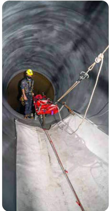
Vom Apparatehaus oberhalb der Schynstrasse aus kann die steil abfallende Druckleitung von oben her mit einer Rettungsbahre begangen werden. Als Redundanz wird zusätzlich ein Sicherungsseil dazukommen.
