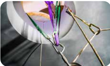
Improvisierte Verankerung für die Umlenkung der Seile, an denen die Bahre sowie zwei Retter/innen in den Stollen abgelassen werden.
