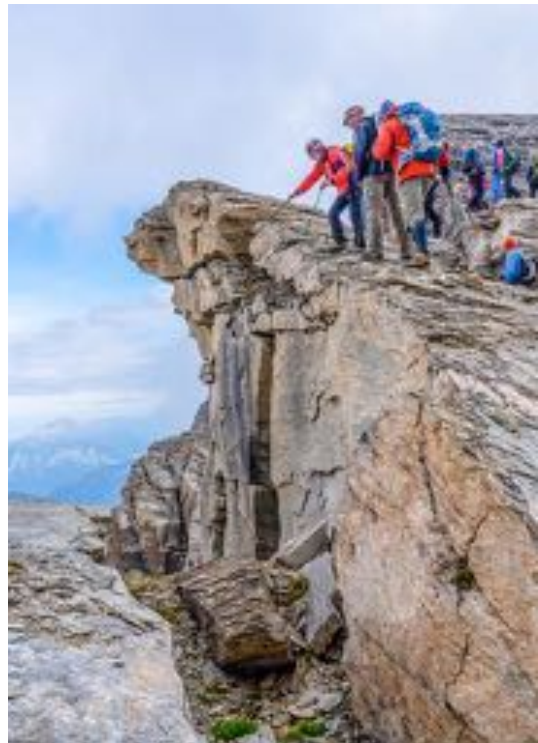
Bergführer Paul Züllig zeigt seiner Gruppe eine Abbruchstelle am Beverin-Südwestgrat, die früher oder später zu einem weiteren Bergsturz in Richtung Carnusatal führen könnte
